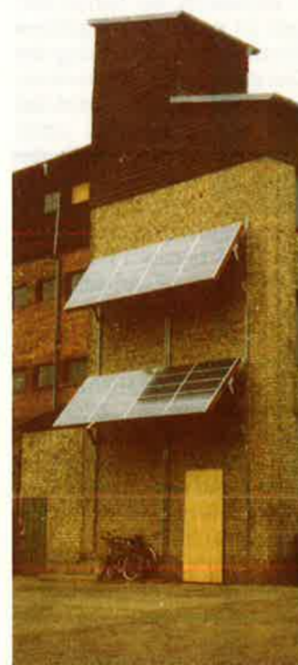
Die Solarzellen der 2 KW - Photovoltaik - Anlage am Ökospeicher
